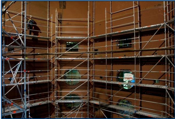
Pohled na vnitřek 200 Mwe spalovací komory kotle s otvorem pro montáž horáka - elektrárny Tušimice II.
