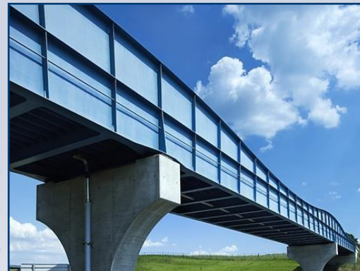
Železniční most Česká republika
