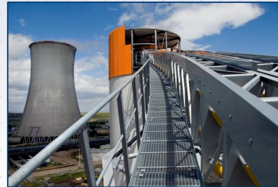
Pohled na FS 05 – přenos popílku do sil – elektrárny Tušimice II
