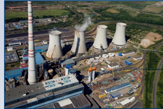
Celkový pohled na rekonstrukci jednotek B23 a B24 – elektrárny Tušimice II
