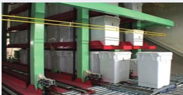
Nebezpečný odpad včetně nemocničního odpadu
