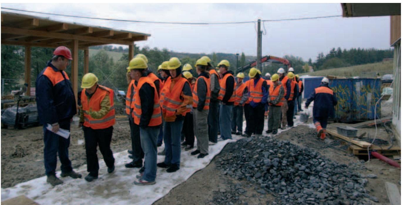
Obrázek č. 8: Přístupová cesta ke staveništi nízkoenergetického domu u Kladna - „červený“ koberec v blátivém terénu položila SKANSKA jenom kvůli nám.
