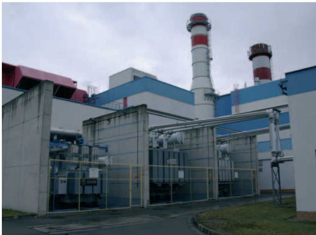
Obrázek č. 1: Vyvedení elektrického výkonu z paroplýnové elektrárny 95 MW - Teplárny Brno, výtopna Červený Mlýn
