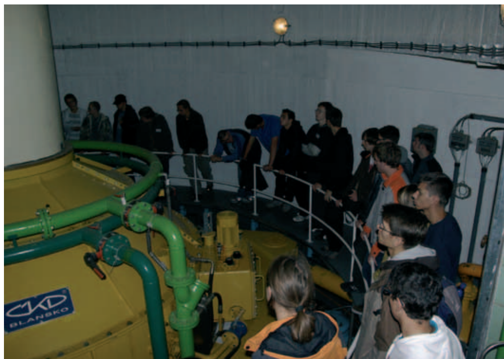
Obrázek č. 3: PVE - Dalešice - Francisova reverzní turbína FR 25 o výkonu 120 MW
