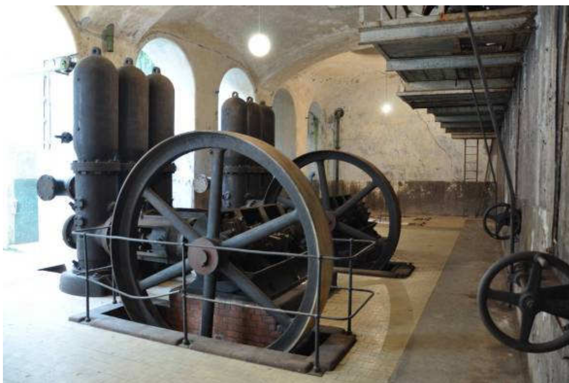
Dóm lapače lísku a vysokotlaká pístová čerpadla se zbytky transmisí
