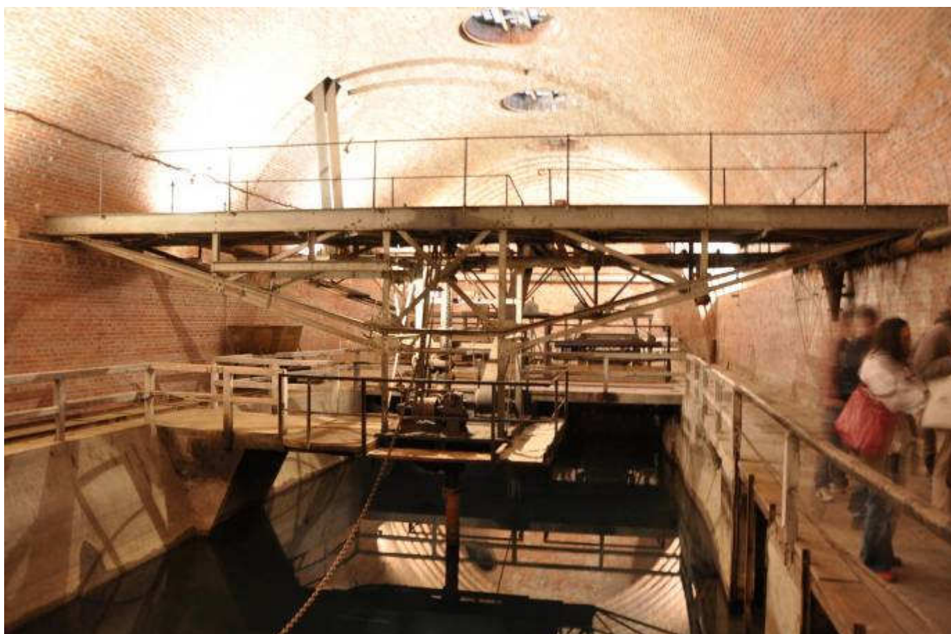
Dóm lapače lísku a vysokotlaká pístová čerpadla se zbytky transmisí
