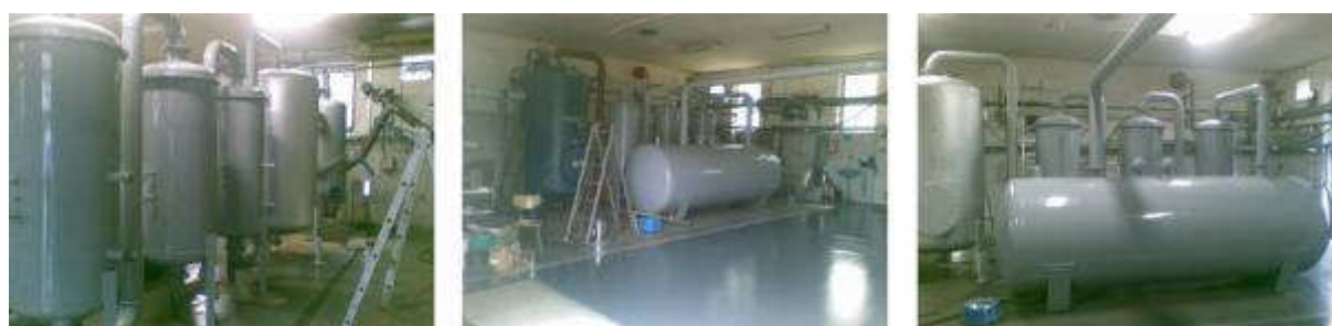
Aktuální instalace (2009) v DSK, foto z firemních podkladů
