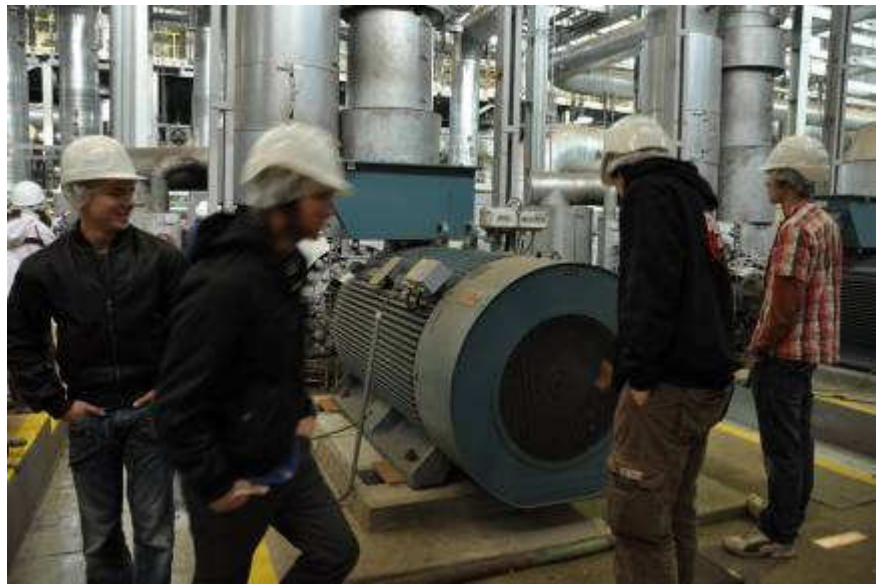
Detail vyvedení tepelného výkonu EMĚ I pro Prahu a pohled na megawattový elektromotor oběhových čerpadel
