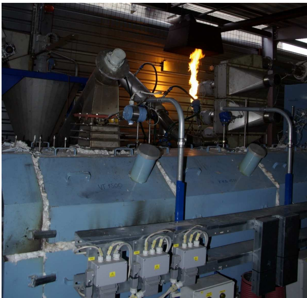
Poloprovozní jednotka PYROMATIC
