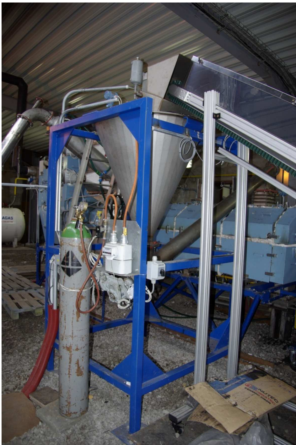
Pohled horní část pásového dopravníku a násypku na odpadní materiál
