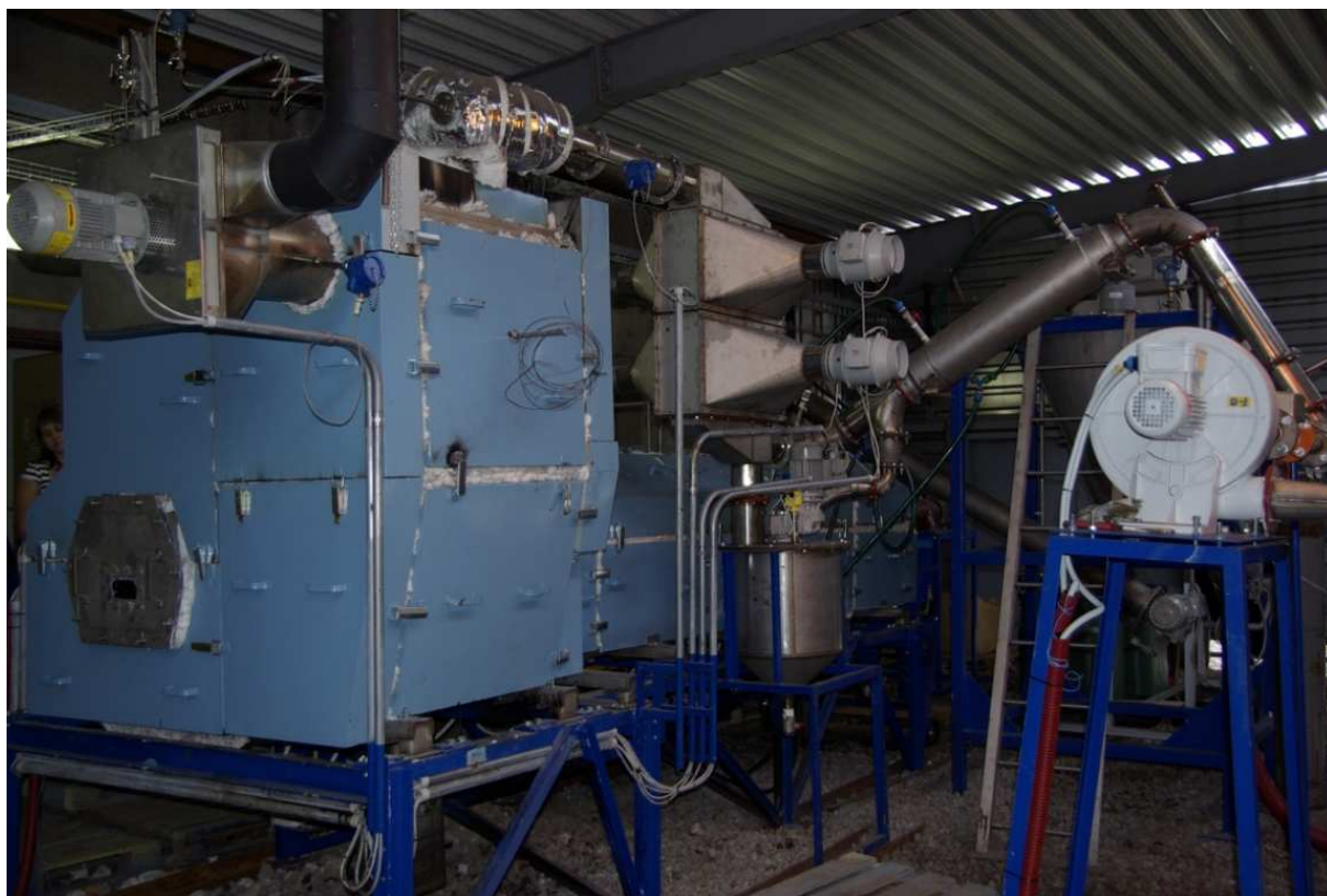
Poloprovozní jednotka PYROMATIC
