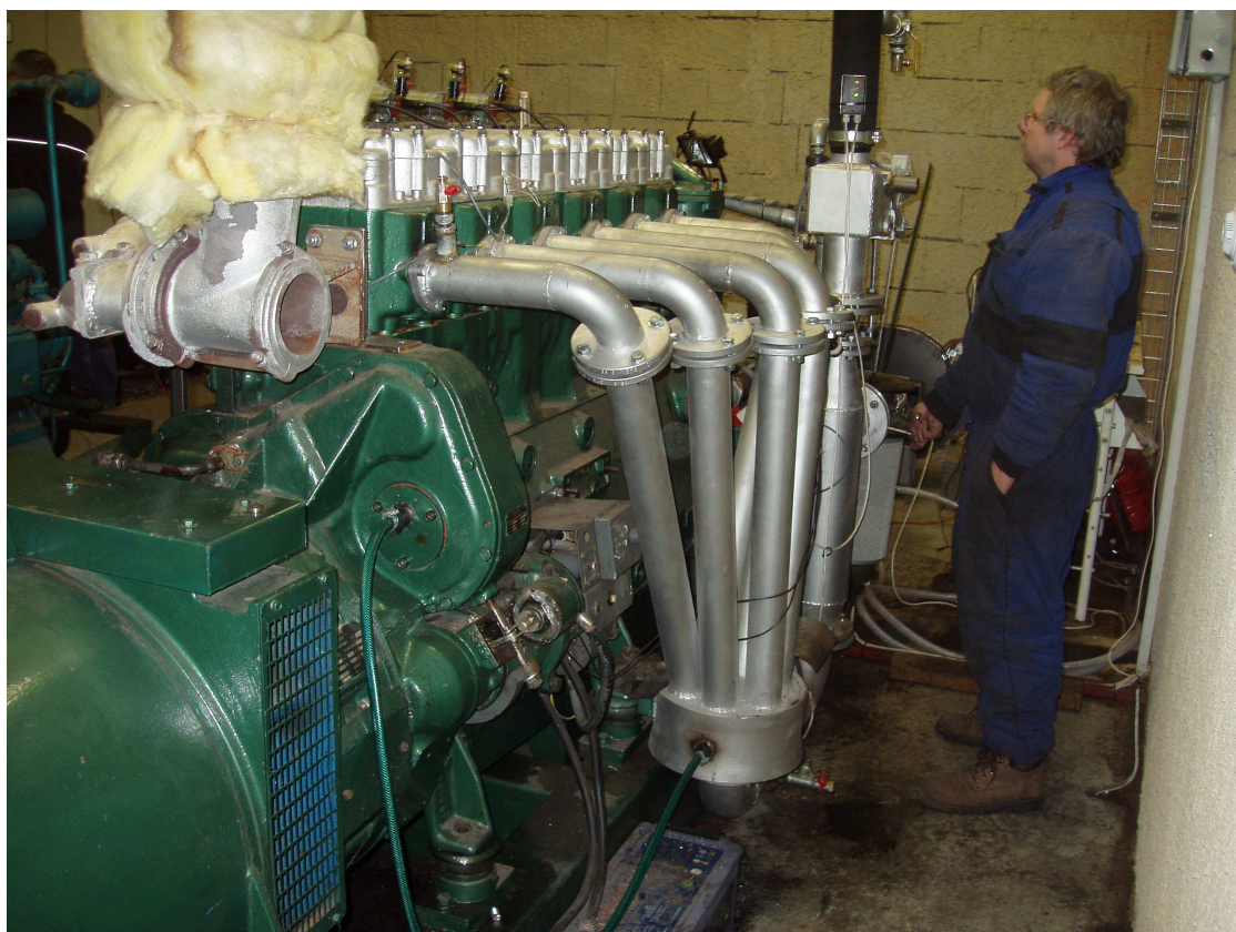
Laděné sání na instalaci firmy EOZ, s.r.o. v Kopřivné
