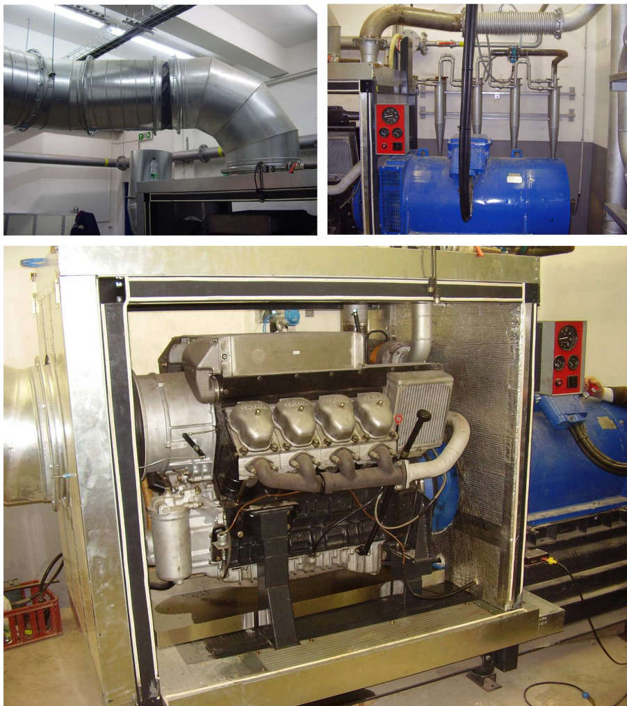
První kogenerační jednotka s motorem TATRA v ČR instalovaná u firmy TŮMA
