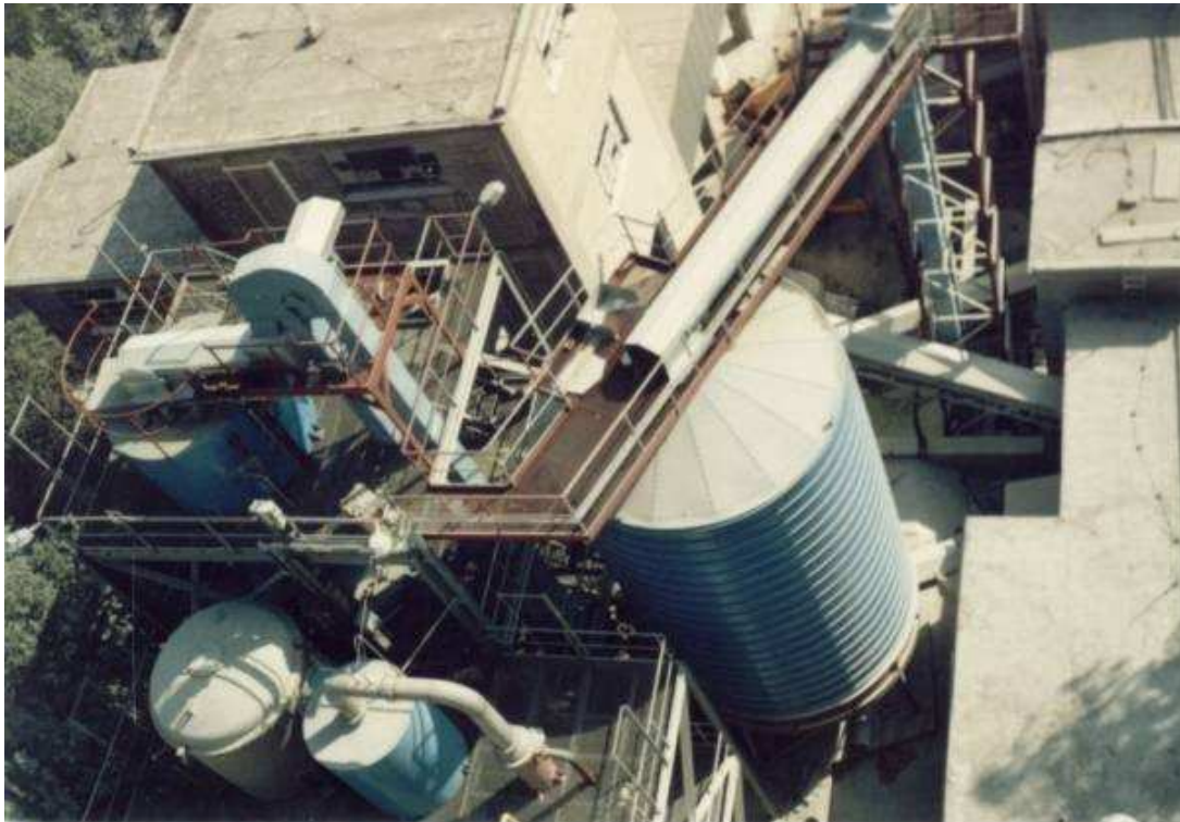
Letecký pohled z komína cementárny a vápenky na dnes již neexistující zařízení ATEKO
