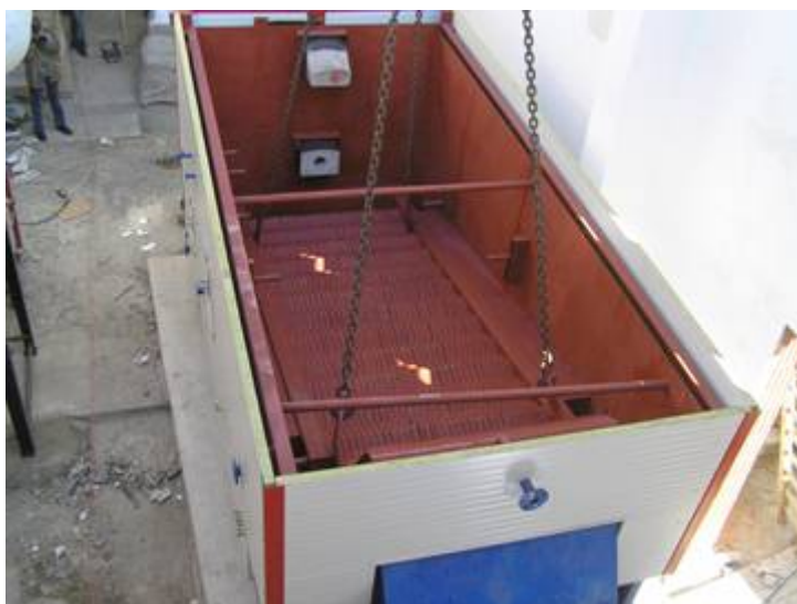
Obr.2 - Pohled do spalovací komory (posuvný rošt) po usazení a před instalací vyzdívky
