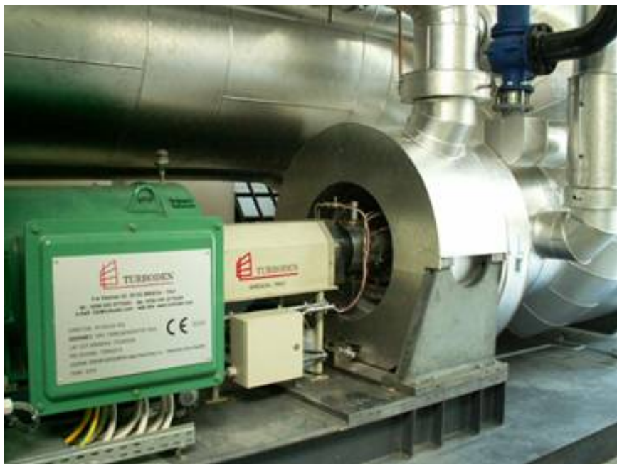
Obr.6 - Pohled na vlastní turbínu jednotky ORC
