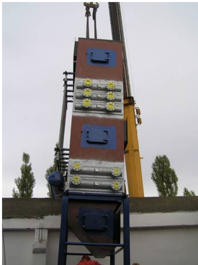
Obr.4 - Instalace olejového a vodního ekonomizéru
