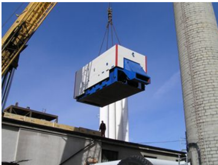
Obr.1 - Instalace kotle termoolejového kotle na biomasu
